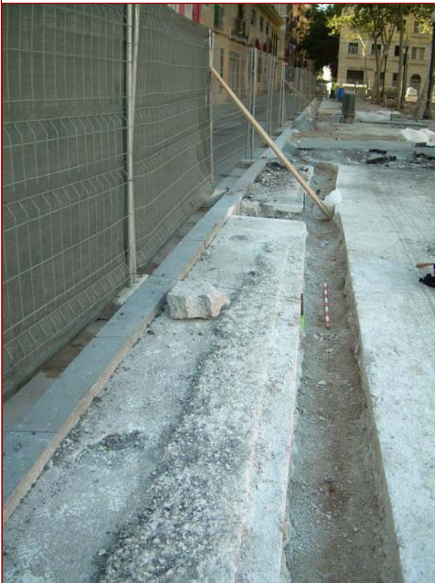
Foto 1. Vista general Rasa 1
