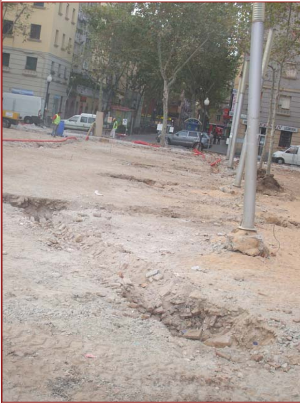
Foto 17. Rasa 5, vista general.
